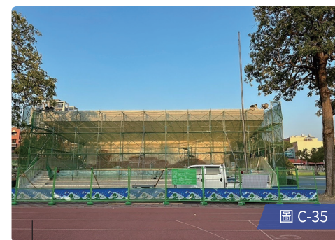
圖 C-34 / 工程進行依職安規定架設 施工圍籬、鷹架以及覆網
